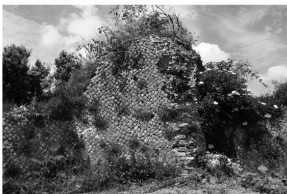
Figura 4. Telesia , cinta muraria: torre circolare (in alto) e torre quadrangolare con ammorsature angolari in blocchetti parallelepipedi (in basso) (foto G. Renda).
