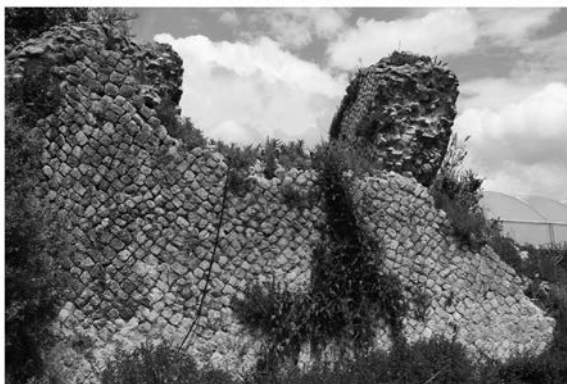
Figura 5. Telesia , cinta muraria: particolari con paramento in opera incerta lungo i versanti settentrionale e meridionale (foto G. Renda).
