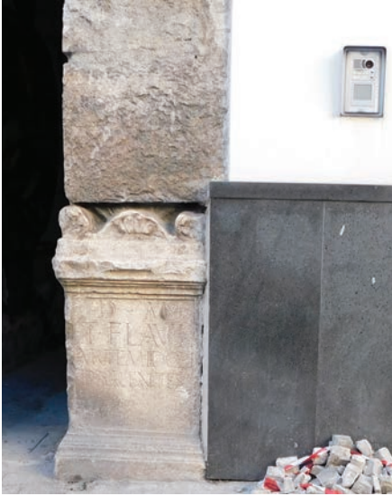
Figura 15. Nola, via Anfiteatro Laterizio: ara funeraria romana usata come pietra d'angolo di un edificio moderno.
