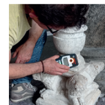
Tramite un rilevatore di elementi metallici è stata osservata la presenza di uno o più elementi metallici alla base della colonna
