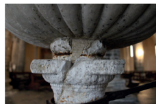
Stuccatura in resina di intervento precedente sull'acquasantiera
