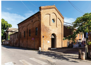
FIG. 1 EX CHIESA DI SANTA LIBERA, SEDE DEL LAPIDARIO CIVICO DI FERRARA.
