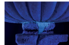
Fotografia in luce visibile della stuccatura di intervento precedente al di sotto della vasca. Si osserva la diversa colorazione della stuccatura rispetto alla pietra, indicante la composizione materica differente
