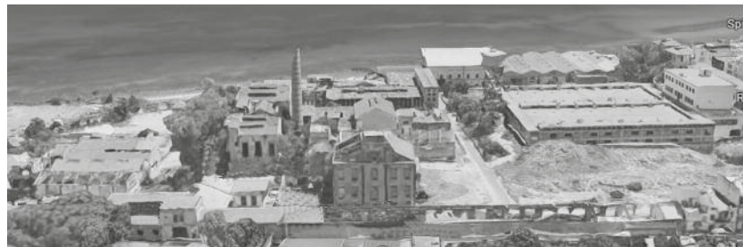
Figura 1.2. L'industria Chimica Arenella, oggi in stato di abbandono.
