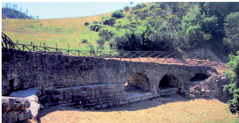
Figura 6. Via Flaminia: ponte a tre archi a Cantiano – località Pontericcioli (PU).
