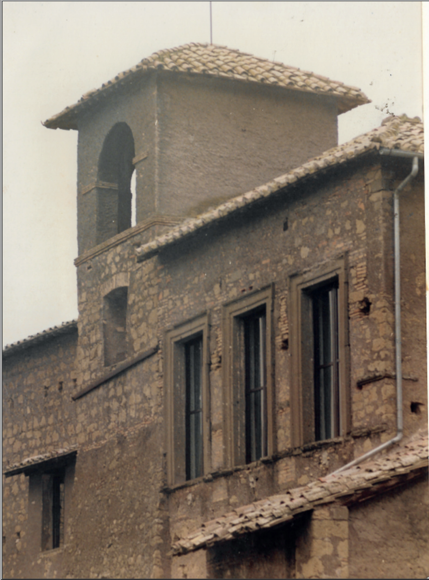
Fig. 7. Torre mediana (rilievo fotografico dell'autore) – foto n. 46.
